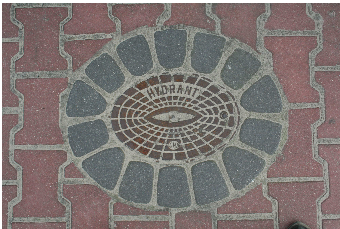
Fot. nr 2 Wykończenie nawierzchni jezdni w obrębie hydrantów podziemnych
