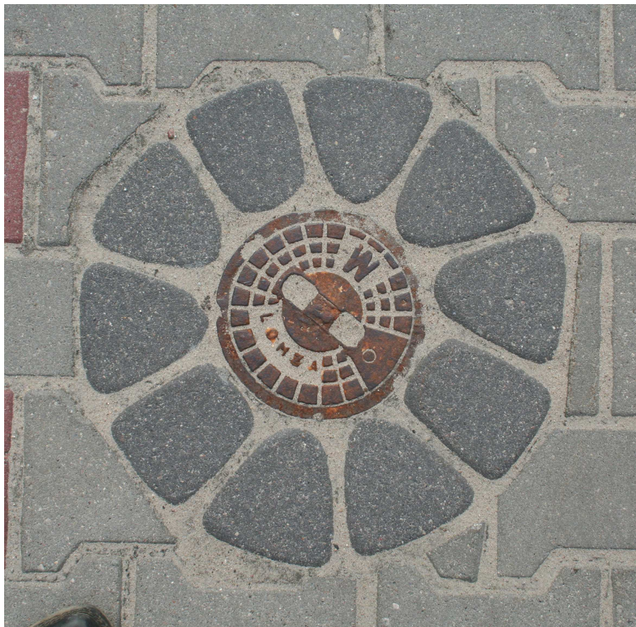
Fot. nr 3 Wykończenie nawierzchni jezdni w obrębie zaworów wodociągowych
