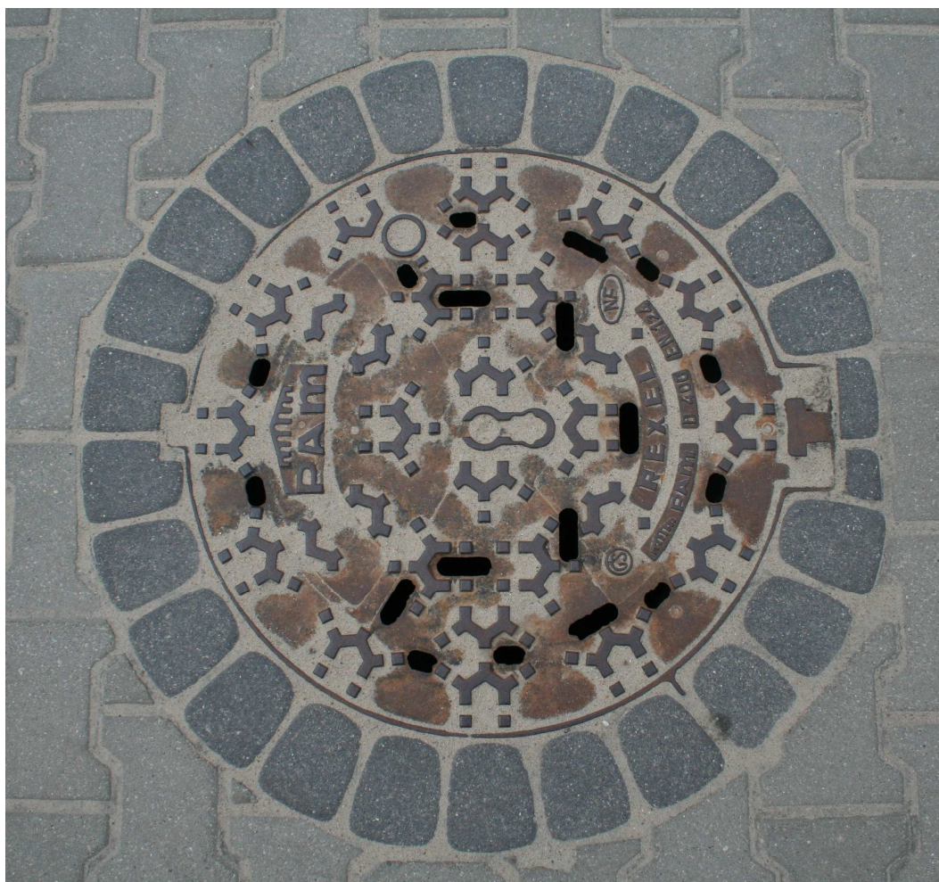
Fot. nr 1 Wykończenie nawierzchni jezdni w obrębie studni KD i KS
